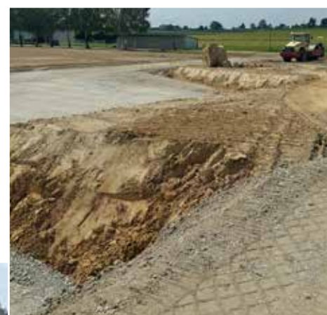
Le drainage en arête sur le terrain en gazon naturel
