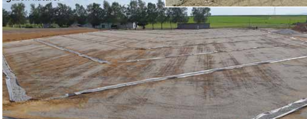
Le drainage en arête sur le terrain en gazon naturel
